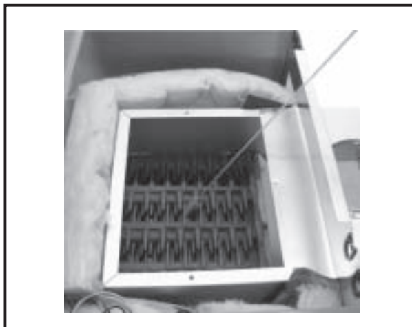
Bild: Reinigung Rauchgaszüge
